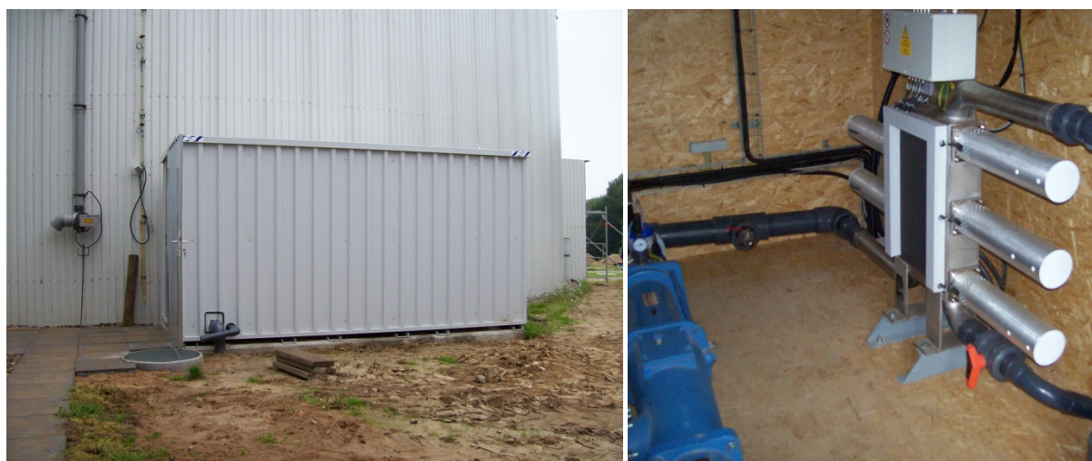
Rysunek 1: Pojemnik z wyposażeniem zewnętrznym i wewnętrznym (z modułem ultradźwiękowym i pompą)
